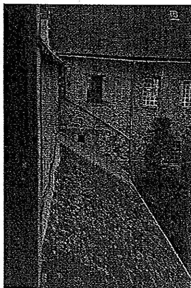
Fig. 1 – Perspective depuis l'échafaudage de la façade vers l'est, au-dessus du toit du collatéral sud. Au fond, la paroi ouest du bras de transept présumé roman, englobée dans le corps de bâtiment de la mairie.
