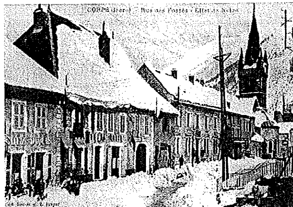
Les fossés enneigés au début du siècle dernier. Circulation impossible.
